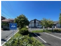
【公共施設のEV充電施設】
