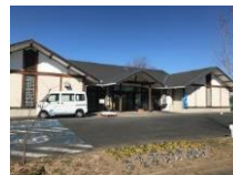
【太陽光発電設置施設】
