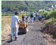
未舗装農道の舗装
