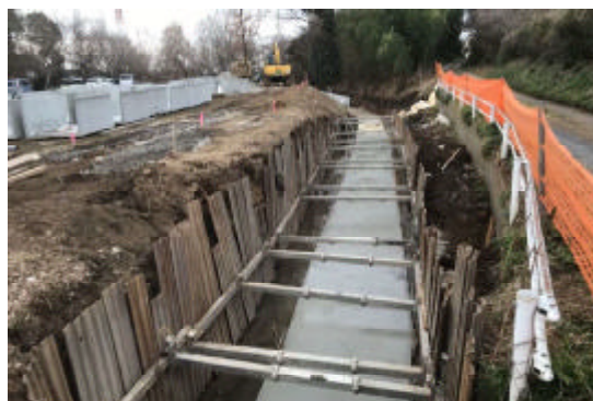
3面張りコンクリート水路の工事
