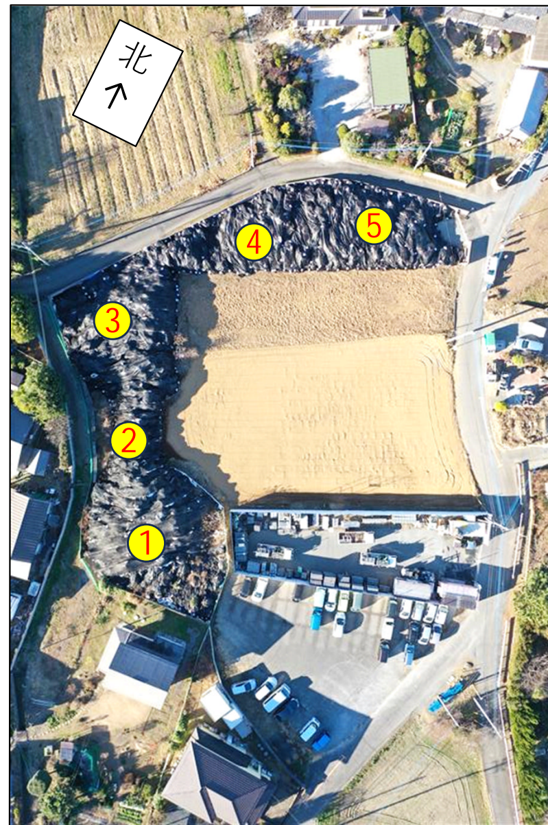
現場全景（R7.12.22日時点）
