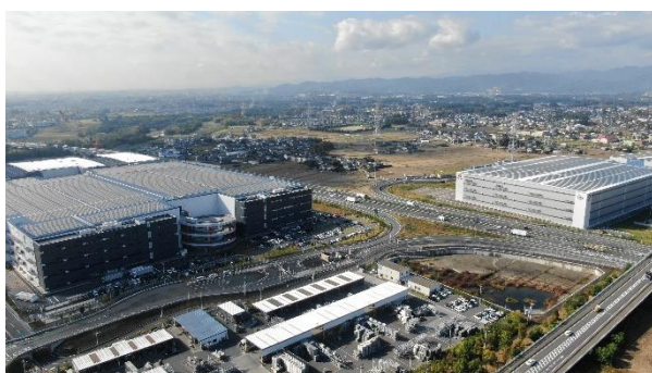
坂戸西スマート I C 周辺の 産業団地（坂戸市）
