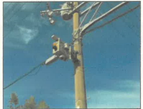
II 型カメラ (50 台) → 人流測定 AI + 車両接近通知 AI 「車が近づきます、ご注意ください」
