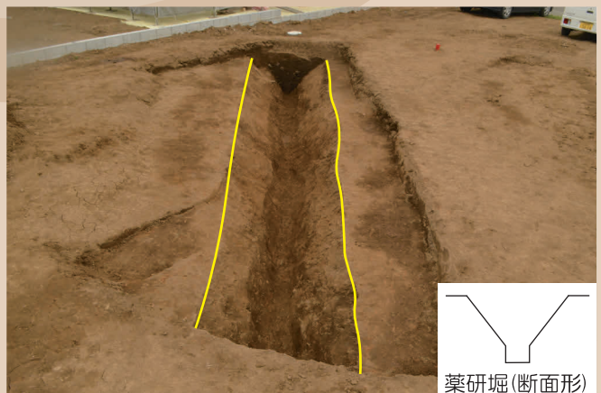
1号溝完掘状況写真
