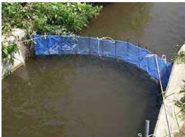
流出防止を目的とした網の設置例
