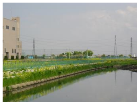
●景観に配慮した護岸
