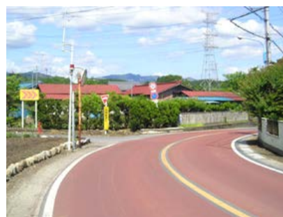
◆交通安全対策（多和目地内）
