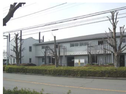
◆駅周辺駐輪場
