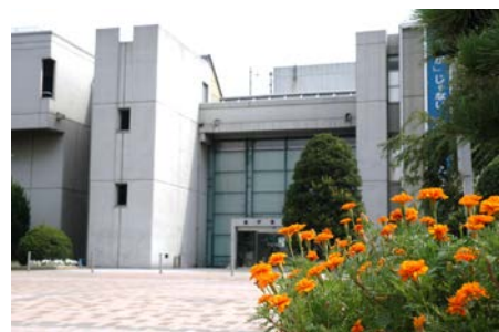
◆坂戸市役所庁舎
