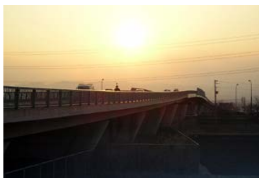
◆坂戸入西大橋（新川越坂戸毛呂山線）
