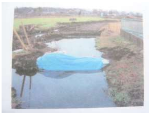
(写真 11 従来の川の上・下流を堰き止め)
