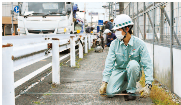
アスファルトの修繕範囲を決定するため、測量を行っています。
