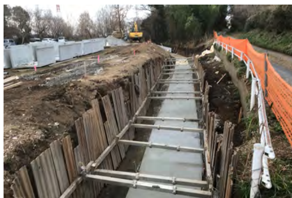
3面張りコンクリート水路の工事
