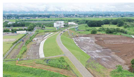
工事現場写真（7月15日現在）
